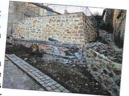
Mais les travaux ne pouvaient en rester là ; pour que ce petit coin de fraîcheur soit terminé, après avoir refait les joints du mur de l'abreuvoir dans l'été, une porte en fer a été aménagée afin de permettre l'accès à la citerne, en cas de problème. Le trottoir en béton a été cassé et refaçonné de façon à éviter les marches et des gros boulets en fonte ont été placés pour interdire le stationnement des voitures.
